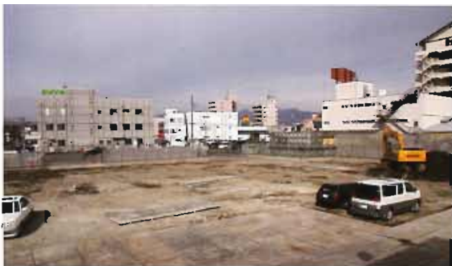
新キャンパス建設工事の様子(2009年1月)
