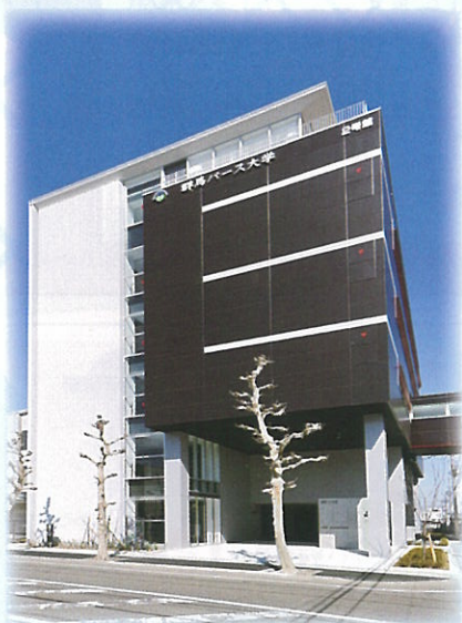
2号館(検査技術学科棟) 平成25年2月28日竣工
